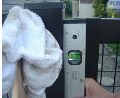
(補強、基礎工事)
